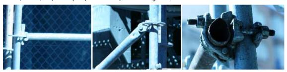
As barras que formam a ligação devem ser tubos circulares ocos de aço ou alumínio. As travessas e longarinas também podem ser tubos retangulares ocos. A resistência dos diferentes tipos de ligação estabelece-se numa base de dados, modificável e ampliável pelo utilizador.
